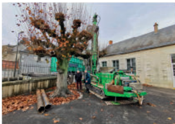
Étude phase 1 - Réalisation du forage d'essai
